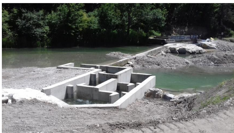
Roubion à Pont-de-Barret (26) [source SMBRJ 2020]
