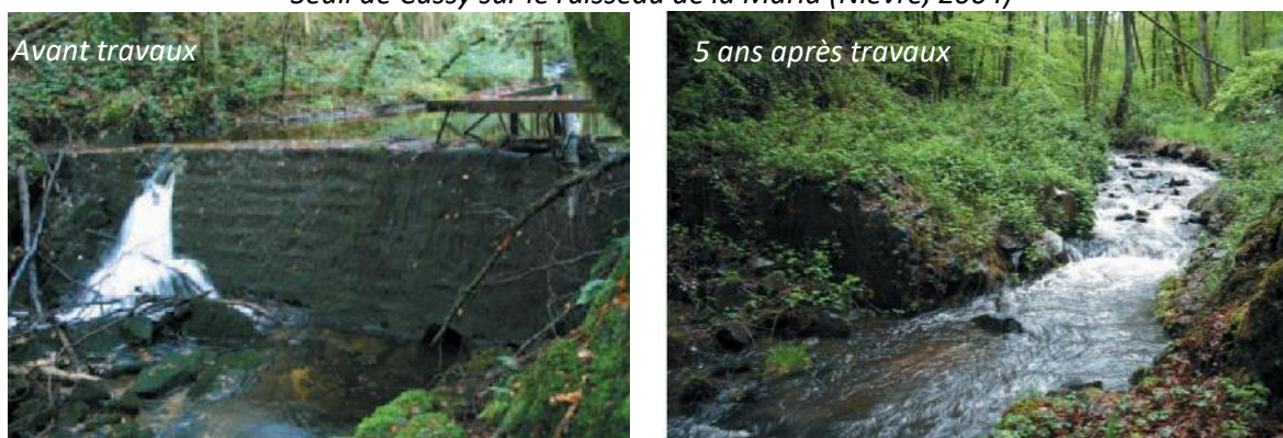
Figure 2 : Exemples d'opérations d'effacement de seuil
