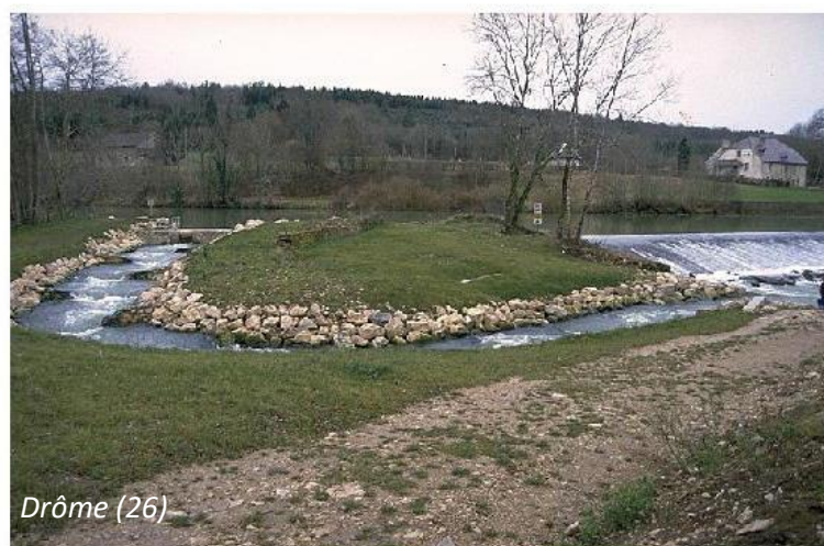
Figure 4 : Illustration et schéma de principe d'une rivière de contournement (source Guide technique pour la conception des passes naturelles, GHAAPPE, 2006)
