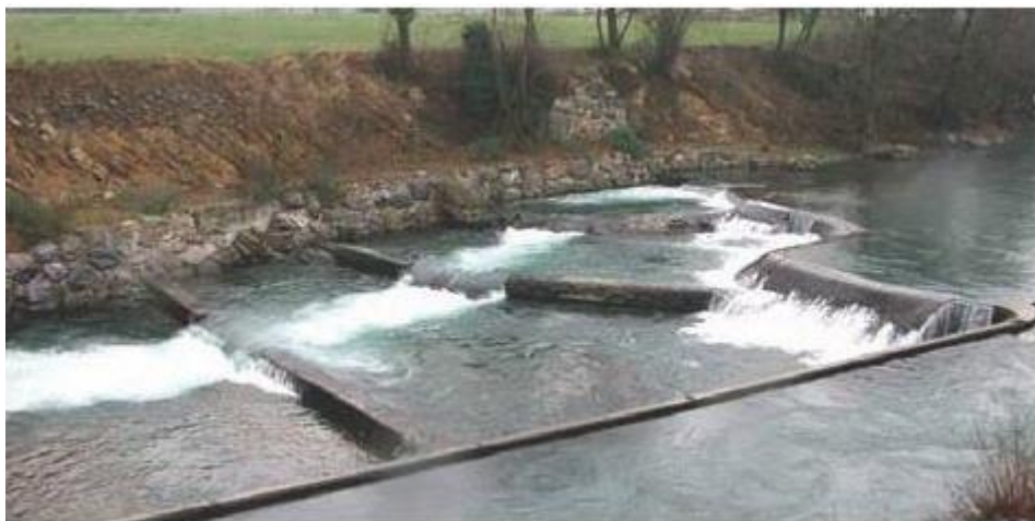
Figure 6 : Illustration d'un exemple de pré-barrages (source Plan d'action pour une politique apaisée de restauration de la continuité écologique, OFB, 2023)
