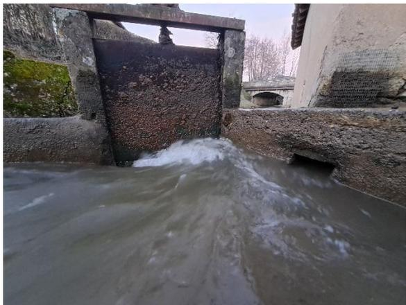
*Ouverture pour prise d'eau du lavoir en rive droite du seuil (vanne fermée)*
